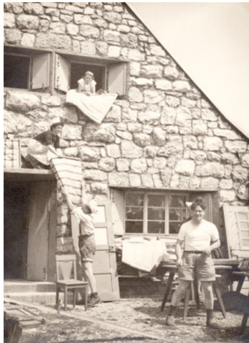
Freiwillige bei der Hüttenrenovation, 1953
